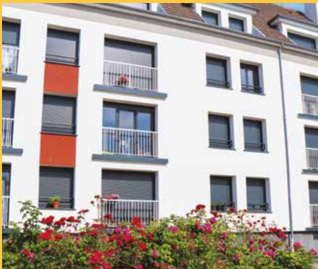
Les 32 logements du chemin du Fort ont bénéficié d'importants travaux d'isolation.
