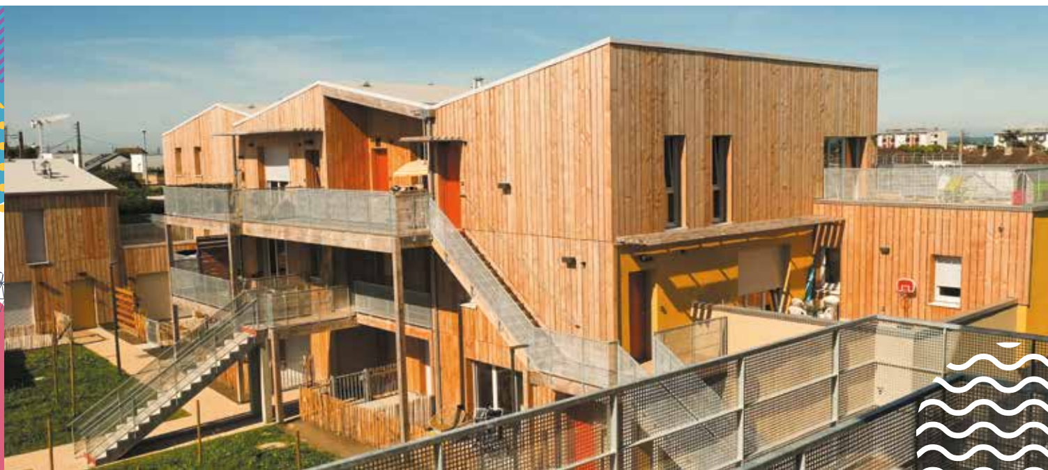
Inolya se doit d'être exemplaire en terme de « trajectoire carbone » et de réduction de ses émissions, comme avec sa dernière résidence livrée dans le quartier Rethel à Caen. Une réalisation remarquable labélisée E2C1, bâtiment biosourcé et BBC Effnergie 2017.
