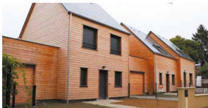
Les premiers logements Inolya labellisés BEPOS EFFINERGIE 2017 - LABEL E3C2 et biosourcé niveau 2.
