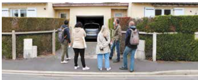
Les candidats du concours EnergieSprong en visite dans nos logements de Saint-André-sur-Orne.
