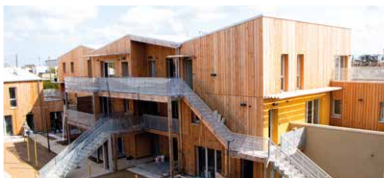
Une nouvelle résidence biosourcée et performante dans le quartier Rethel de Caen.
